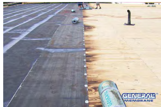
Fig. 4- posa con fissaggio meccanico per punti, Tetto Caldo Fig. 5- posa con fissaggio meccanico per punti su legno
