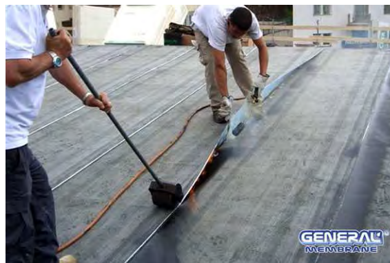
Fig. 9 – Tecnica di giunzione: Rullo
