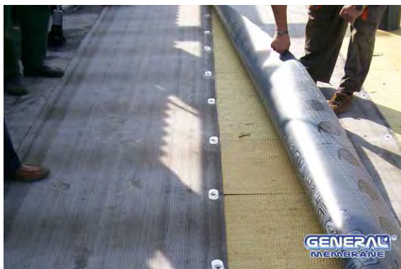
Fig. 4- posa con fissaggio meccanico per punti, Tetto Caldo Fig. 5- posa con fissaggio meccanico per punti su legno
