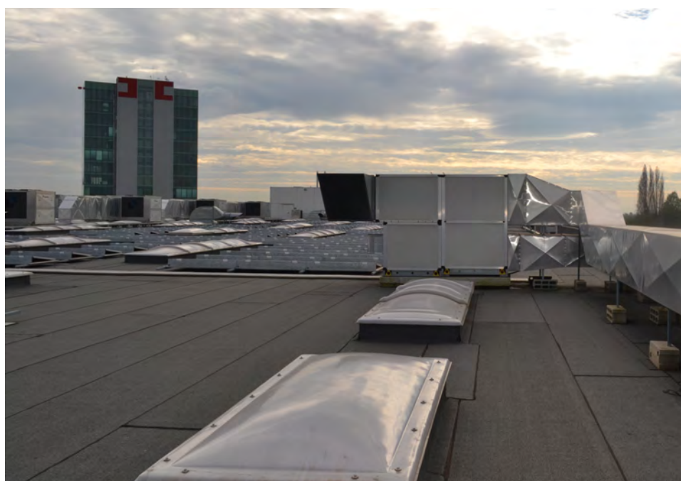
Fig. 32 – Copertura (oggetto visita ispettiva ITC) realizzata con doppio strato
