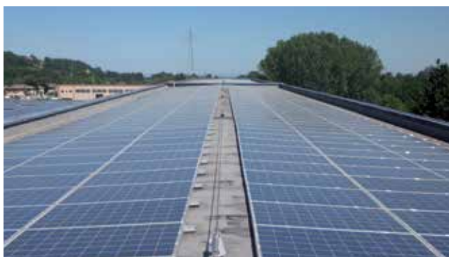
Module fotovoltaice montate pe acoperiș impermeabilizat cu membrană bituminoasă prin sistemul General Fix EVO
