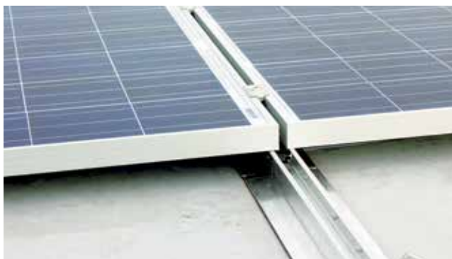
Module fotovoltaice montate pe acoperiș impermeabilizat cu membrană sintetică prin sistemul General Fix
